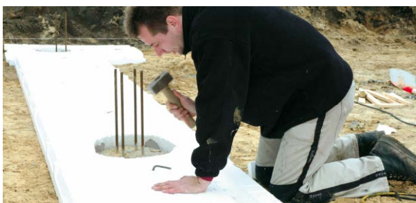
3 Met bodemplaten verbindingen maken tussen de hoeken.
