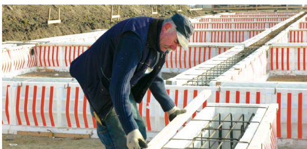
7 Houten ribben (afm. 50 x 70 mm) in bovenbeugels leggen en klampen bij hoeken. Voor PowerKist® XL geldt een aangepast verwerkingsadvies. In de verwerkingsvoorschriften wordt deze uitgebreid toegelicht.
