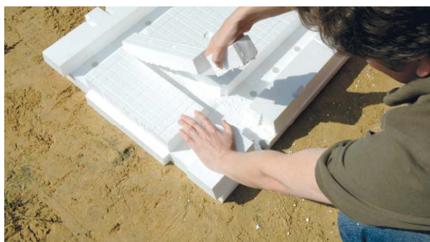
Eén bodemplaats voor rechte stukken, eind-, hoek- en T-stukken dankzij handige afritsstrook
